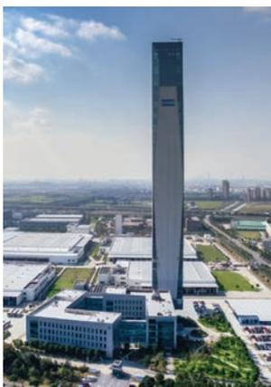
Con i suoi 235,6 metri di altezza, la **torre di test di KONE a Kunshan** comprende 12 vani che possono essere riconfigurati per le prove delle nuove soluzioni e dei componenti per edifici alti. Le dotazioni permanenti includono un ascensore ad alta velocità che trasporta i visitatori all'ultimo piano e allo showroom alla velocità di 10m/s. Questo è il primo ascensore a due piani del mondo dotato della tecnologia ultraleggera **KONE UltraRope®**.
